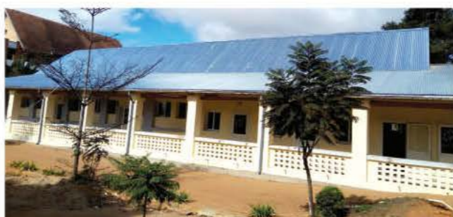
CHU Fianarantsoa - Bâtiment en cours de réhabilitation
