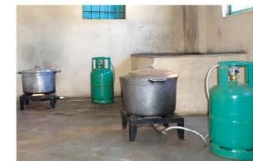
La cuisine alimentée en énergie propre
