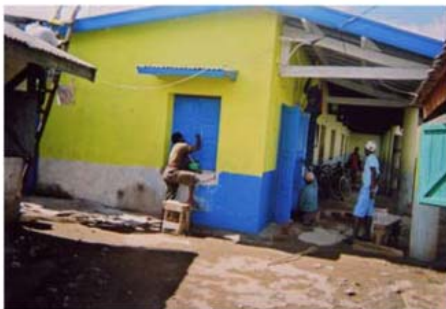
Déroulement des travaux
